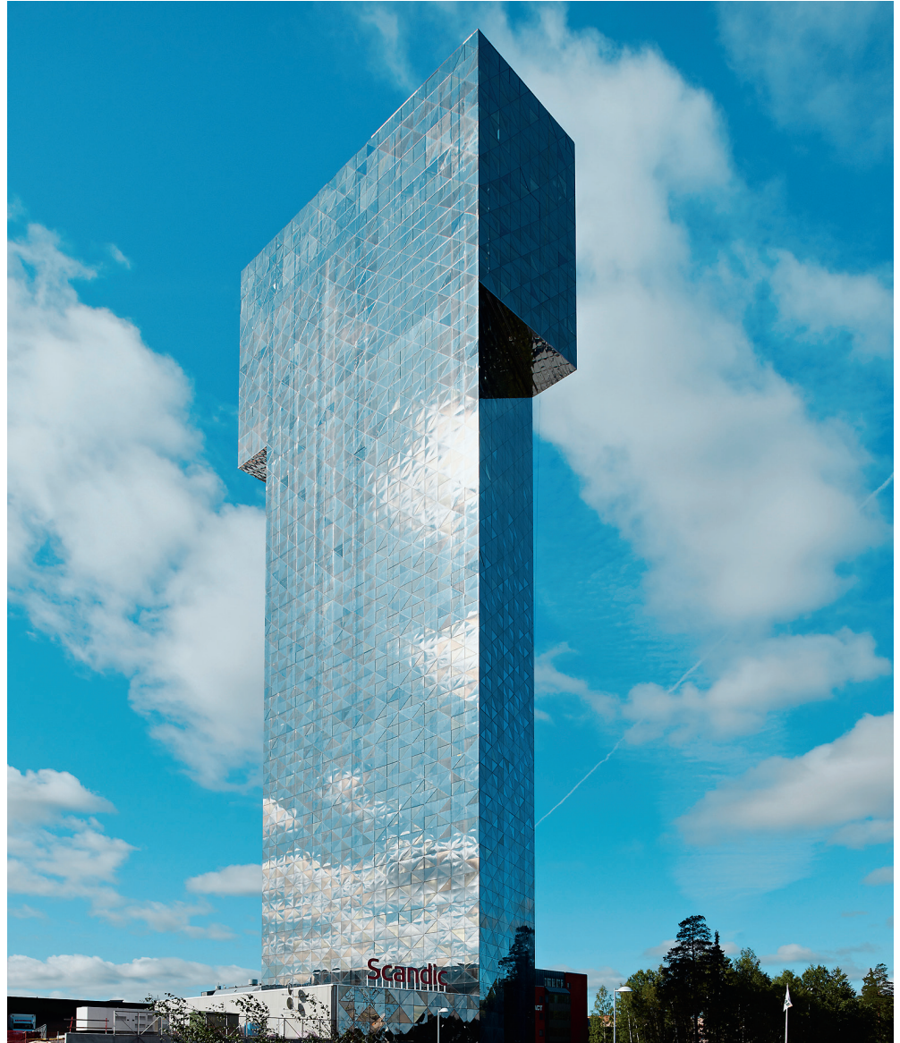
Pohjoismaiden korkeimman hotellin Scandic Victoria Towerin savukaasusuojaus perustuu käynnissä oleviin puhaltimiin ja savunrajoittimiin.
